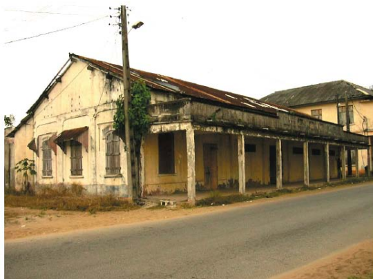
Le bâtiment de la Société Commerciale Ouest Africaine Photo: EAMAU 2003.
