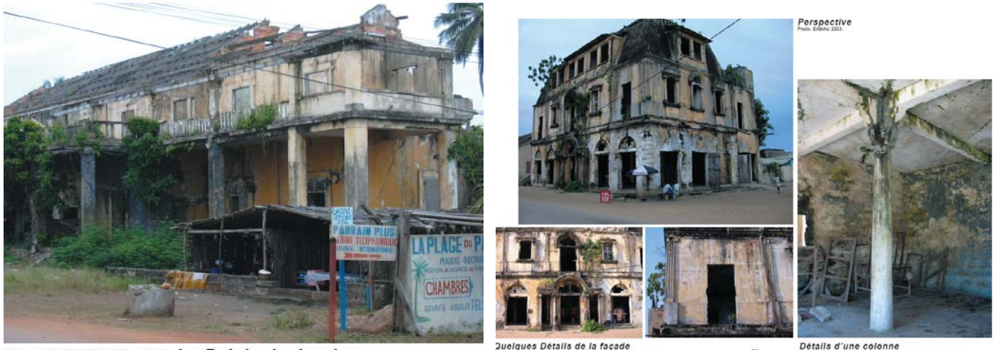
Photographie n°9 : Vue des bâtiments en mauvais état
